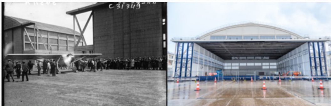
Avant/après. A gauche, en 1925, le mythique monoplane "Spirit of St. Louis" de Charles Lindbergh sort de son hangar à l'aéroport de Paris-Le Bourget, et à droite, les huit panneaux rénovés du hangar H1. Crédit photos : BnF et Vincent Roucard (LBGP) pour Groupe ADP
