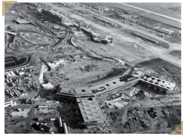
Le Chantier d'Orly Ouest
