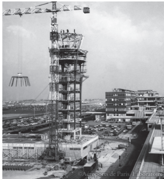
Chantier de construction de la tour
