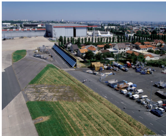
Le hangar N7
