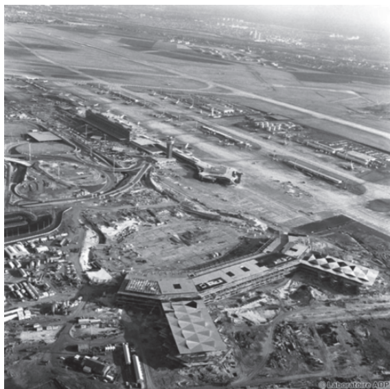
Le Chantier d'Orly Ouest.
