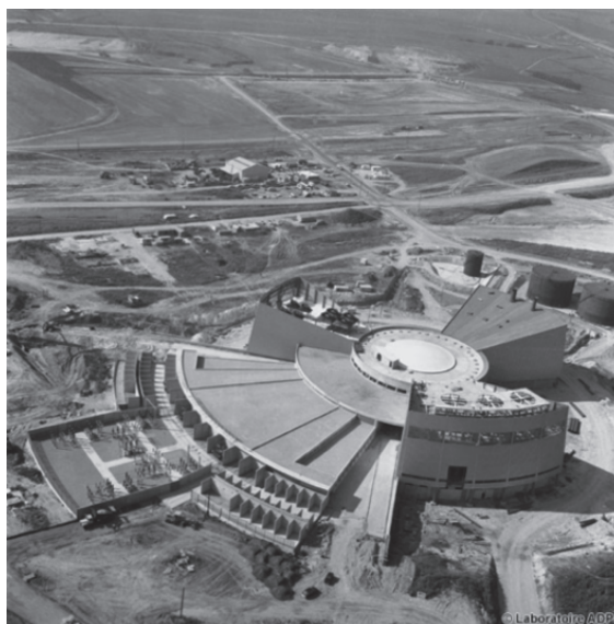
La centrale thermique
