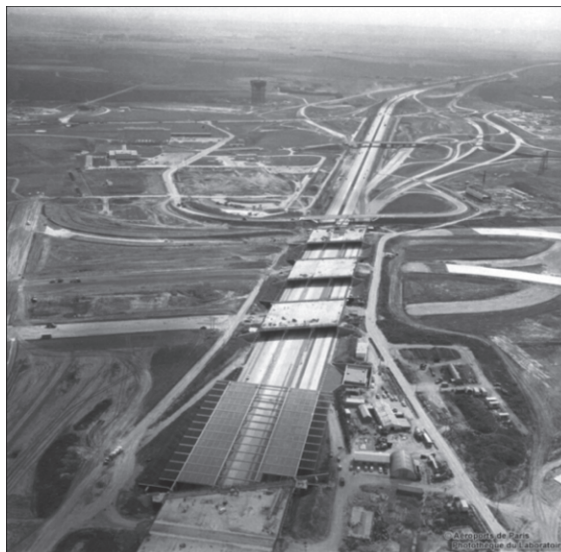
Constructions des ponts sur l'autoroute A1
