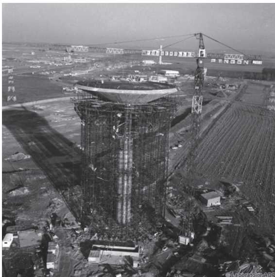
Chantier du château d'eau
