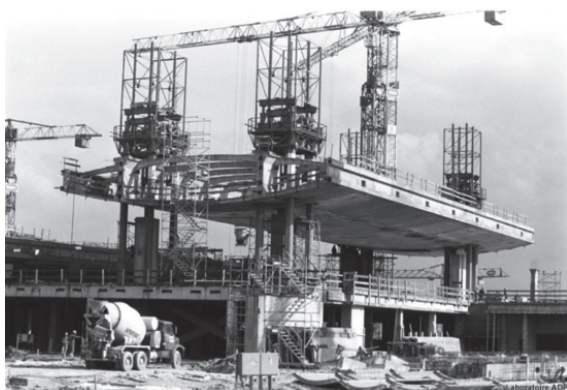
Pose d'un caisson
