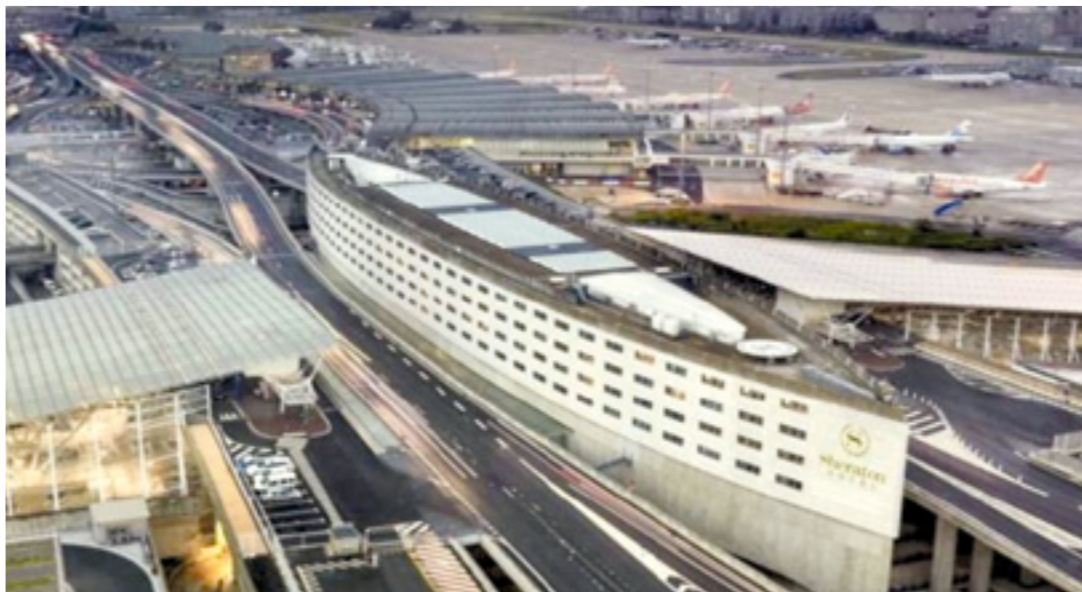
La gare RER-TGV de Roissy, inaugurée le 13 novembre 1994 située au-dessous de l'hôtel Sheraton
