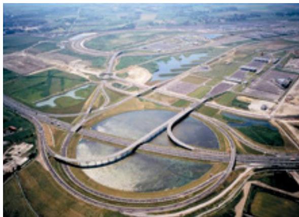
Terminal, côté français du tunnel sous la Manche
