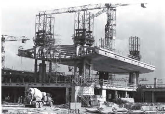
Pose d'un caisson
