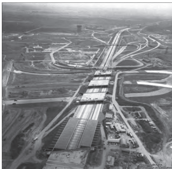
Constructions des ponts sur l'autoroute A1
