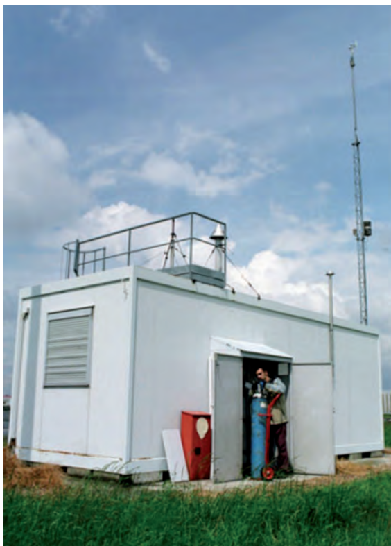
Station de surveillance de la pollution de l'air
