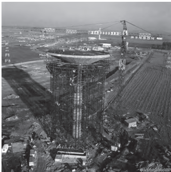
Chantier du château d'eau
