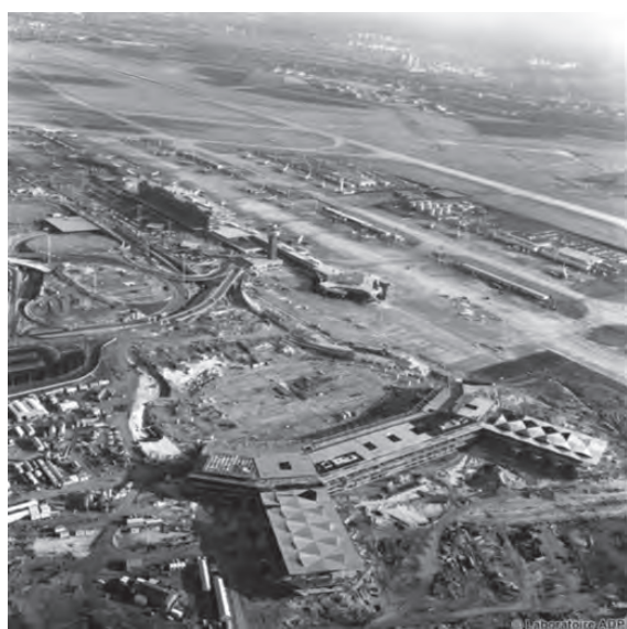
Le Chantier d'Orly Ouest.
