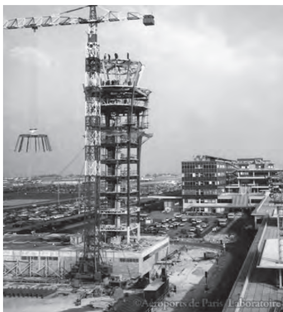
Chantier de construction de la tour
