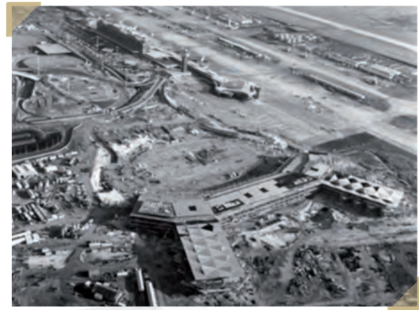
Le Chantier d'Orly Ouest
