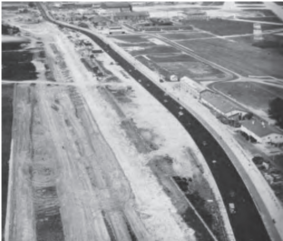
Vue aérienne de la déviation au sud du chantier (septembre 1956)
