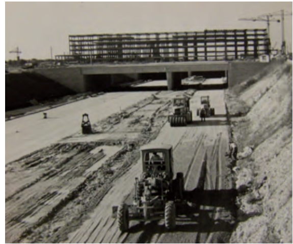
Le chantier de la RN7 sous la future aérogare (1958)
